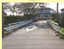
橋梁点検調査
