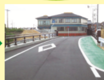
橋梁修繕・耐震補強工事後
